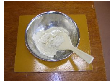
⑥粉末の壁材に水を入れて柔をらかくませます。(耳たぶ程度)
